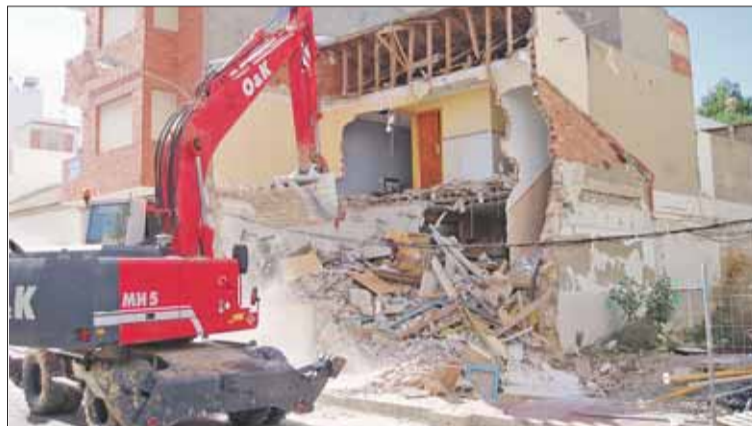
Momento del derribo de la vivienda afectada.
